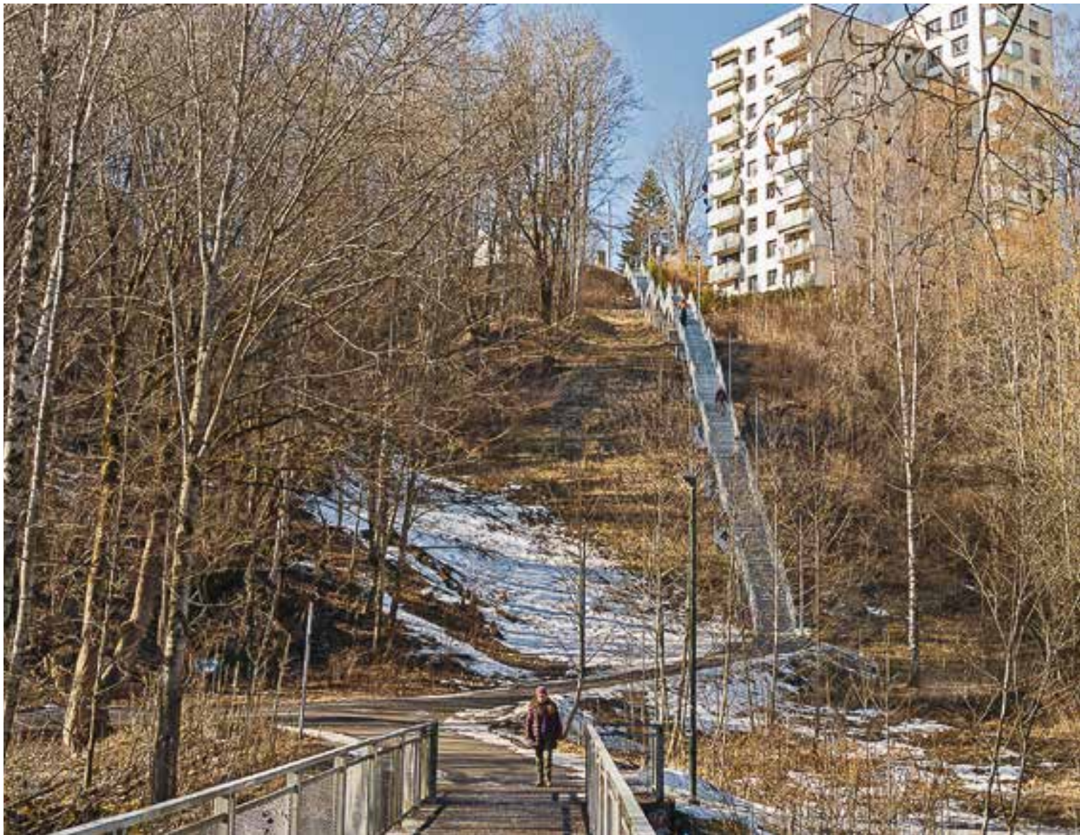
Schody w miejscu skoczni
